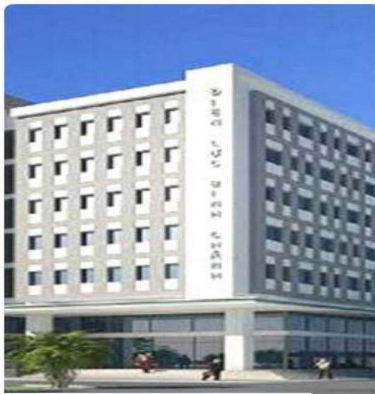
02. Tòa nhà Điện lực Bình Chánh
