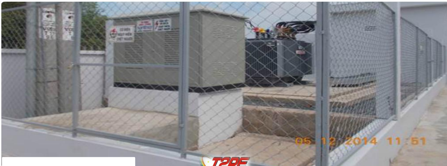
Thi công tủ Kios
